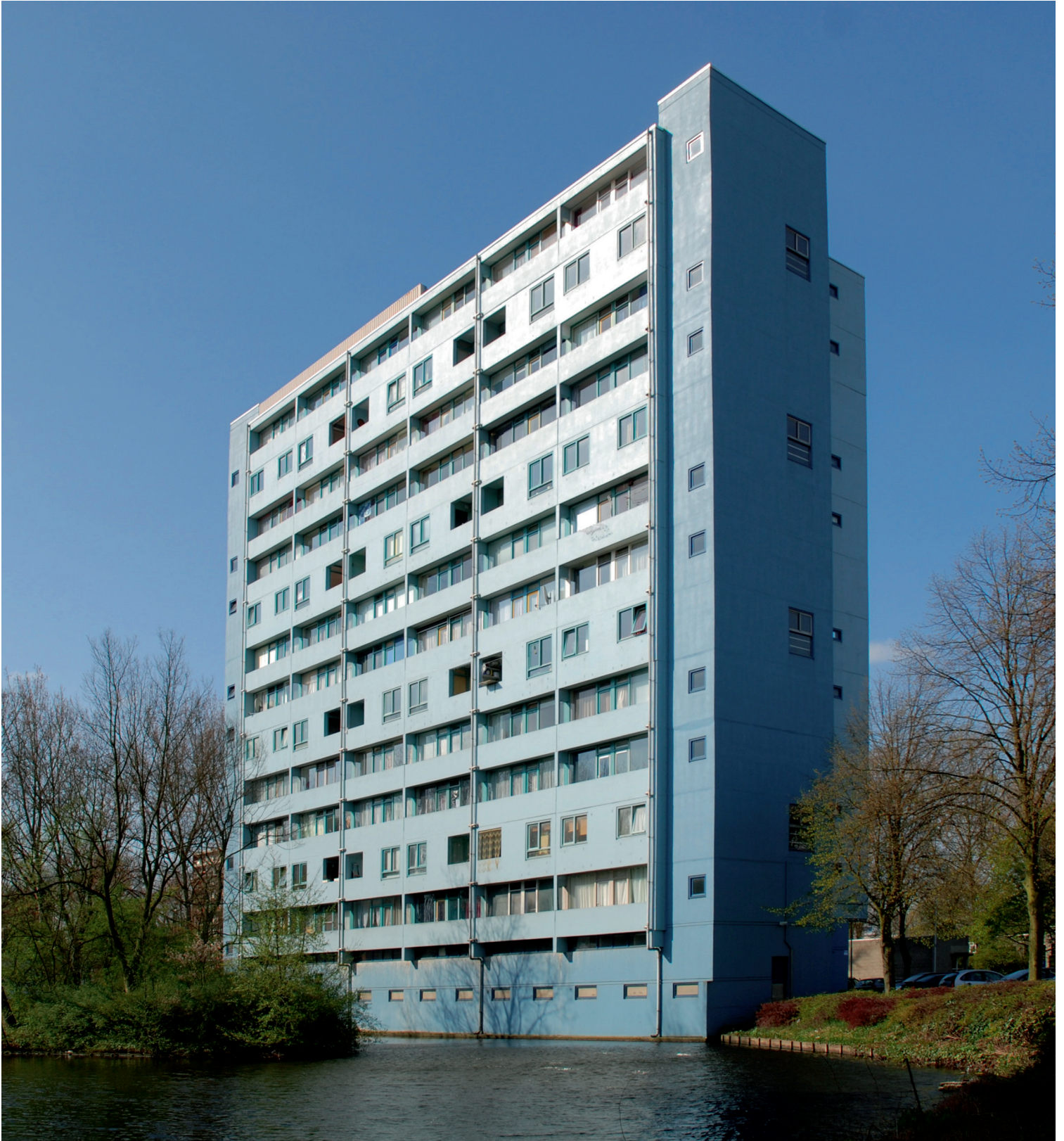
Oostgevel gezien vanuit de Jacoba van Beierenlaan East elevation seen from Jacoba van Beierenlaan
