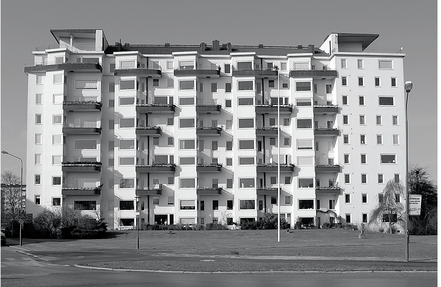
Oostgevel gezien vanaf de rotonde East elevation seen from the roundabout
