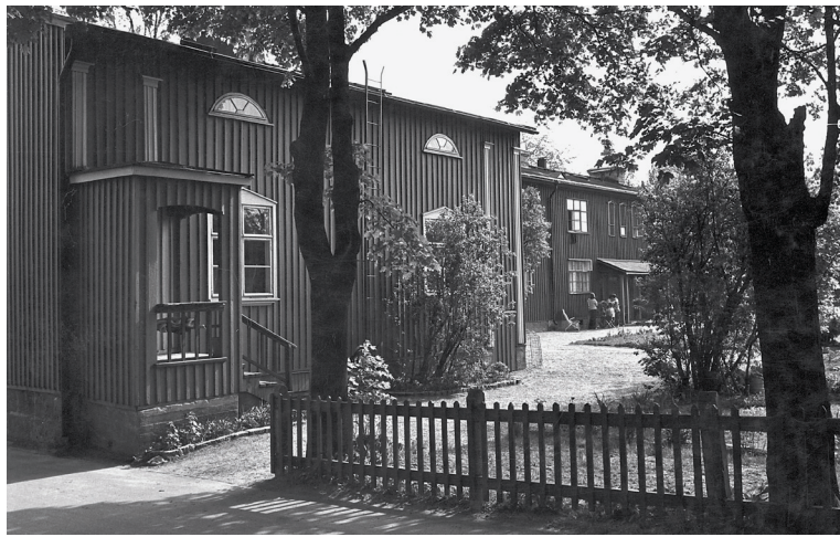
Entree tot het erf vanaf de straat Entrance to woonerf from the street
