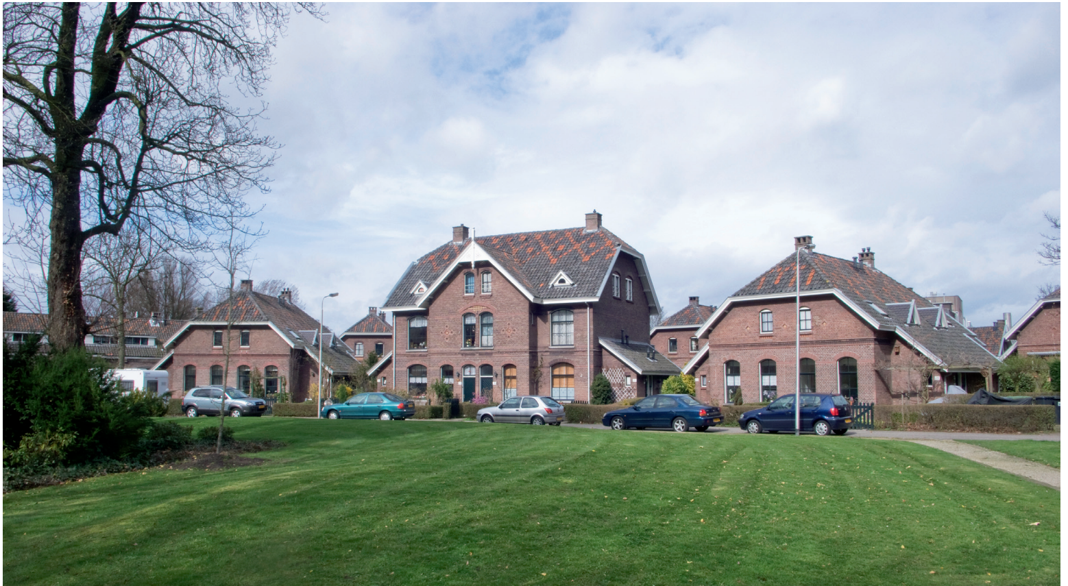
Arbeiderswoningen in het Agnetapark in Delft Workers' homes in Agnetapark in Delft
