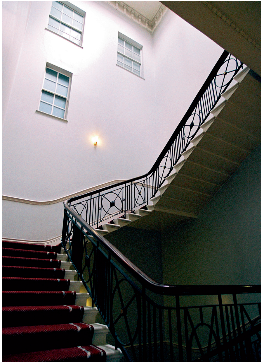
Bovenste deel van het centraal trappenhuis Uppermost part of the central staircase
