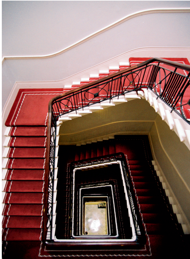
Centraal trappenhuis Central staircase
