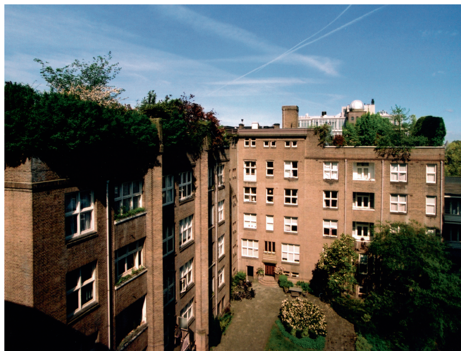
Binnenhof met zicht op de grote daktuinen Inner courtyard with view of the large roof gardens
