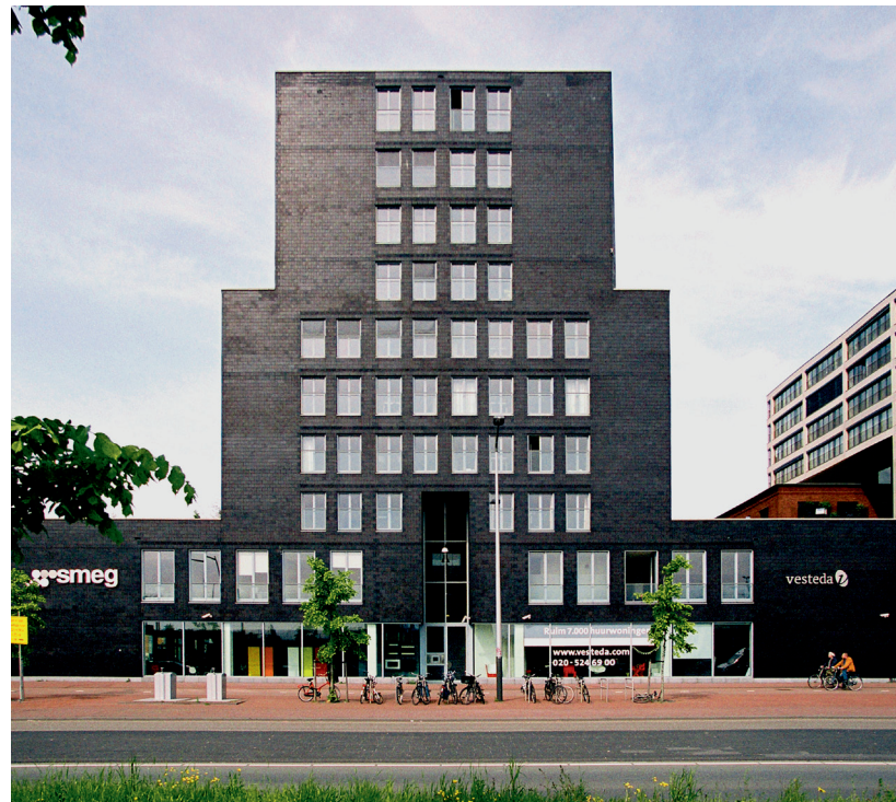
Zuidgevel aan de Piet Heinkade South façade on the Piet Heinkade
