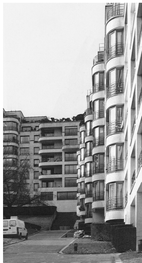
Gebouw voor de Caisse des Dépôts, Parijs - Saint-Cloud, Louis Faure-Dujarric, 1937 Building for the Caisse des Dépôts, Saint-Cloud, by Louis Faure-Dujarric, 1937
