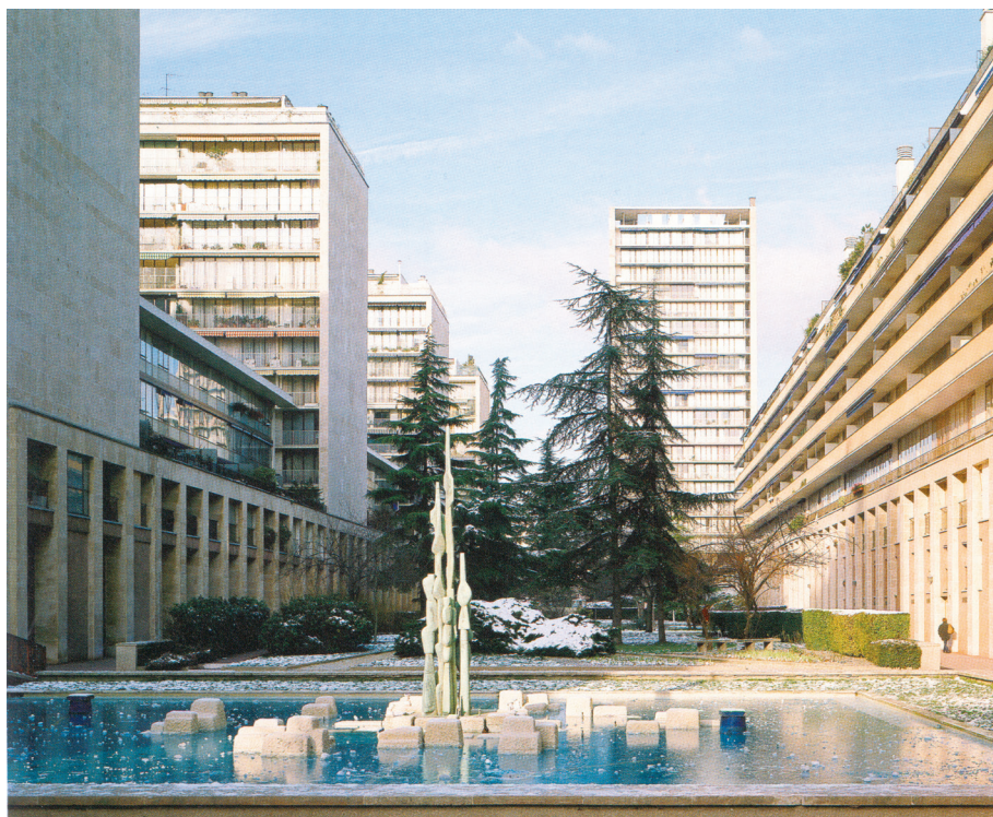
Appartementengebouwen Résidence du Point-du-Jour, Parijs, 16 e arrondissement, Fernand Pouillon Residence du Point-du-Jour apartment buildings, Paris, 16 e arrondissement, by Fernand Pouillon
