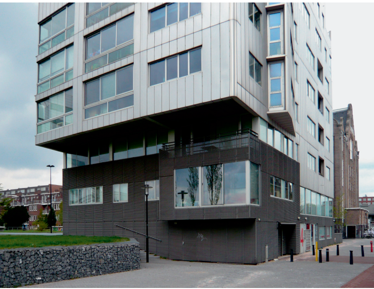
Fietspad tussen het project en de bestaande panden Cycle path connecting the project and the existing buildings
