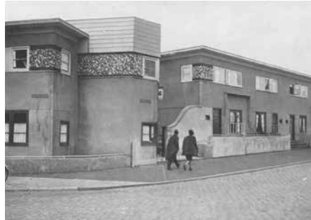
4 Scheveningen, betonwoningen, Westduinweg
