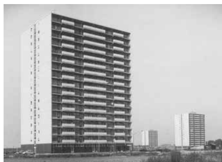
4 Vredenrust, flats Lozerlaan, bron: Valentijn 2002
