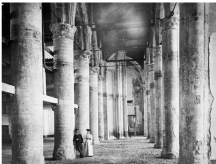
FIGUUR 3.9 De toestand van de kerk in 1898, na het verwijderen van de vloeren.
