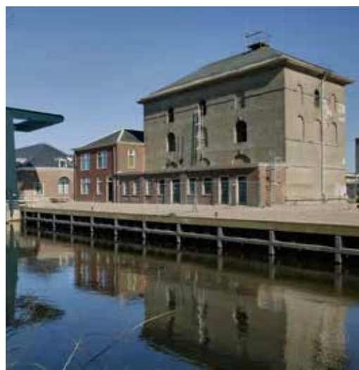
FIGUUR 7.15 Het stoommachinegebouw in 2002, voor de restauratie
