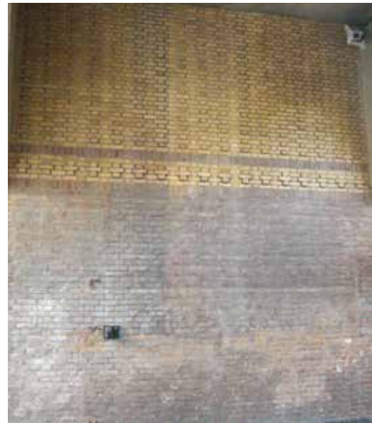
FIGUUR 5.13 Voorafgaand aan de restauratie, die in 2010 startte, was er op verschillende plaatsen geëxperimenteerd met het verwijderen van het schilderwerk van de gevels en het reinigen van het onderliggende metselwerk.
