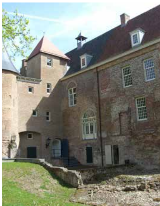
FIGUUR 4.14 De voorgevel van het kasteel na herbouw, 2008
