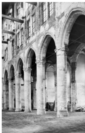
FIGUUR 3.8 De toestand van de kerk in 1898, na het verwijderen van de vloeren.
