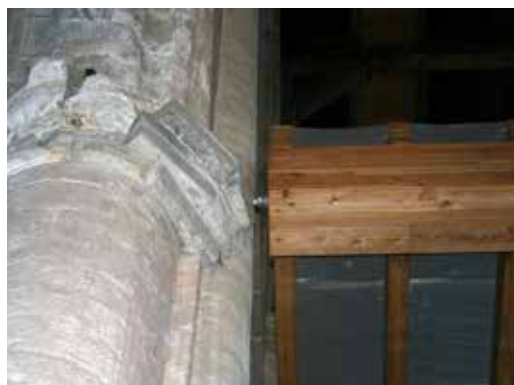
FIGUUR 3.27 Detailopname van de aansluiting van de nieuwe inbouw op één van de zuilen, 2007
