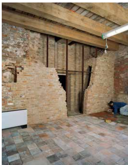
FIGUUR 4.16 Interieur tijdens de herbouw met de nieuwe binnengevel van staal en glas in aanbouw, 2005
