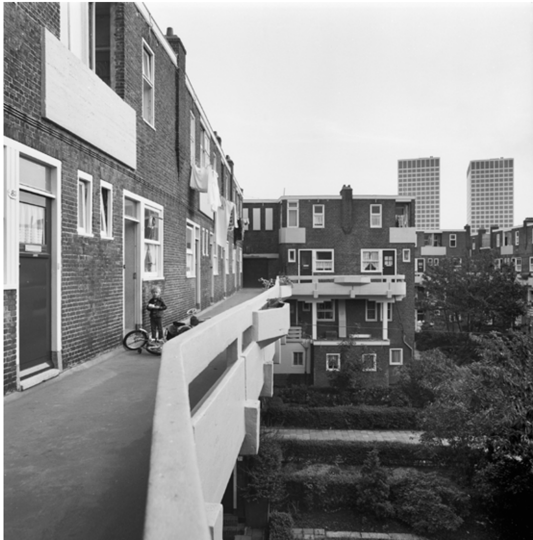
FIGUUR 5.3 Op deze foto uit 1976 is een deel van de betonnen galerij te zien met de geïntegreerde betonnen plantenbakken.
