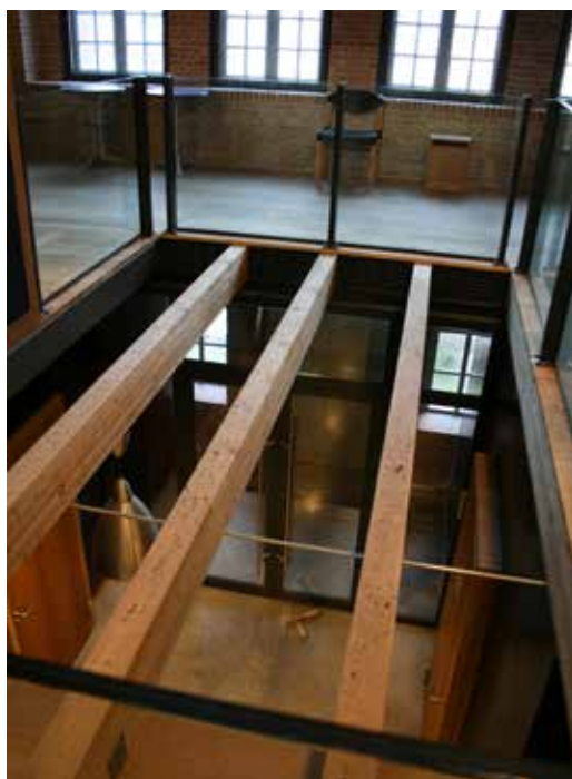
FIGUUR 3.25 De nieuwbouw in het zijship verwijst in zijn vorm- en maatgeving naar de vloeren die de Fransen in de kerk hadden aangebracht en die bij de restauratie in 1892 weer werden verwijderd, 2007
