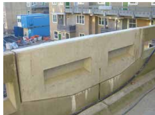
FIGUUR 5.19 Om de betonnen plantenbakken te reconstrueren, werden delen van de balustrade van de betonnen galerij, die stamt uit de tijd van de renovatie van het complex, verwijderd en vervangen door nieuwe betonnen delen met geïntegreerde plantenbak, 2012
