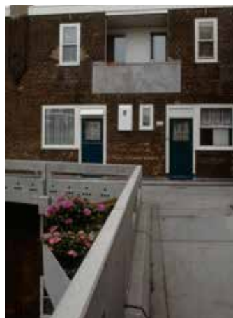
FIGUUR 5.5 Bij de renovatie van het complex werd de betonnen galerij vervangen, werden de plantenbakken uitgevoerd in wit kunststof en werd de indeling van de woningen gewijzigd. De foto uit 1985 toont het eindresultaat met de aluminium kozijnen.
