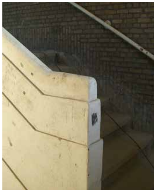
FIGUUR 5.24 In aanloop naar de restauratie bleken er nog oorspronkelijke onderdelen aanwezig, zoals deze trapbalustrade in één van de trappenhuizen, 2012
