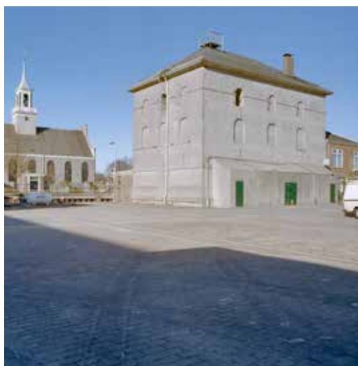
FIGUUR 7.14 Het stoommachinegebouw in 2002, voor de restauratie
