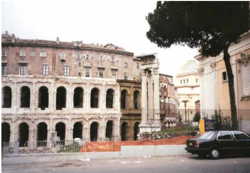
FIGURE 0.1 Een vroeg voorbeeld van hergebruik waarbij het uit de eerste eeuw v.Chr. daterende Teatro Marcello in Rome in de zestiende eeuw werd opgehoogd met een woonverdieping van de hand van architect Baldassare Peruzzi.
