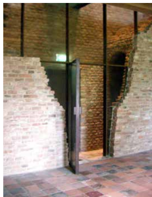
FIGUUR 4.17 Interieur na de herbouw met de nieuwe binnengevel van staal en glas, 2008
