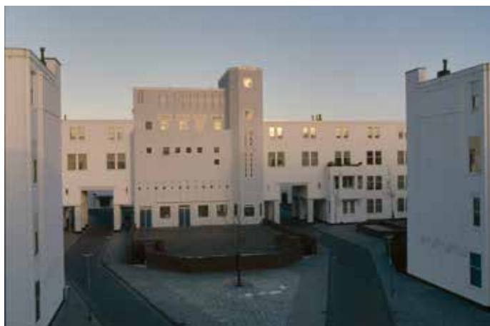
FIGUUR 5.9 Op een mooie zonnige dag in 1990 tonen de wit geschilderde gevels “smetteloos”.
