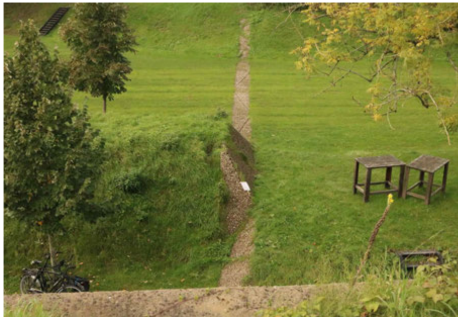
FIG. 4.39 Bunnik (NL), Fort bij Vechten: the concrete slabs defining the perimeter of the strook (strip) (F. Marulo 2019)
