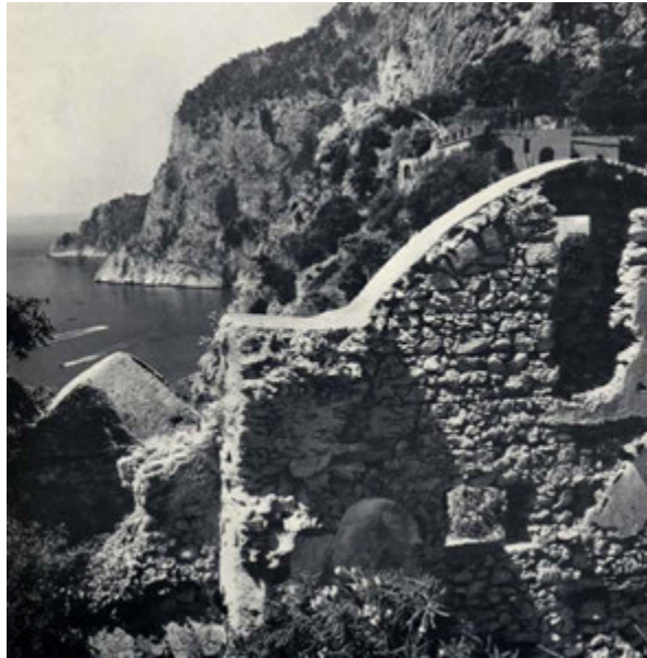
FIG. 3.19 Capri (IT), La Certosa: Mura dirute sullo sfondo della Marina piccola (Ruined walls with Marina piccola in the background), picture of R. Pane (Pane 1954)
