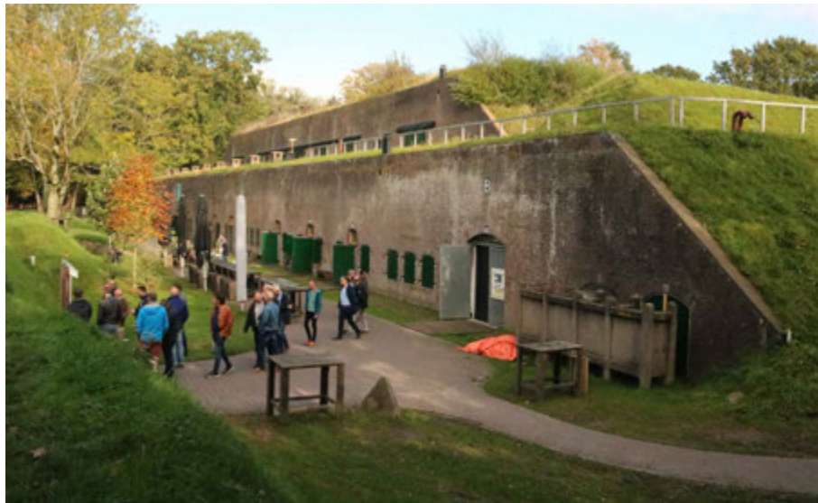
FIG. 4.47 Bunnik (NL), Fort bij Vechten. Bombproof barracks: façade (F. Marulo 2019)
