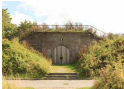
FIG. 4.78 Houten (NL), Fort 't Hemeltje: building E closed for bats (F. Marulo 2019)
