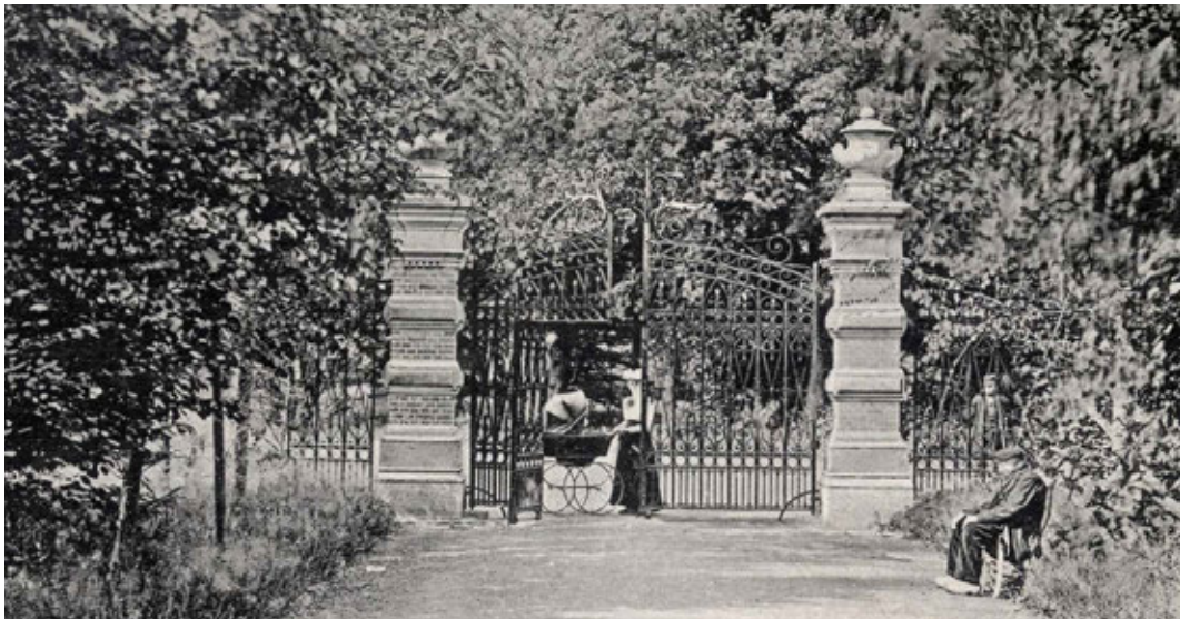
FIG. 7.21 Oostelijk toegangshek aan de Hoofdweg te Paterswolde uit 1856 (Gemeente Tynaarlo) met pijlers van baksteen, natuurstenen dekplaten en smeedijzeren hekken (Bron: Groninger Archieven).
