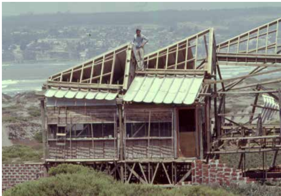
FIG. 2.46 Architect Boris Ivelic designing and building the Hospedería de la Entrada . Ciudad Abierta, ca. 1982. Source: Archivo Histórico José Vial Armstrong e[ad] PUCV.
