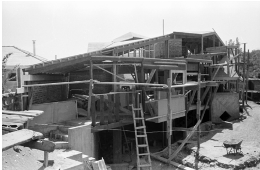
FIG. 2.56 Construction of the façade. Santiago, 1960. Source: Archivo Histórico José Vial Armstrong e[ad] PUCV.
