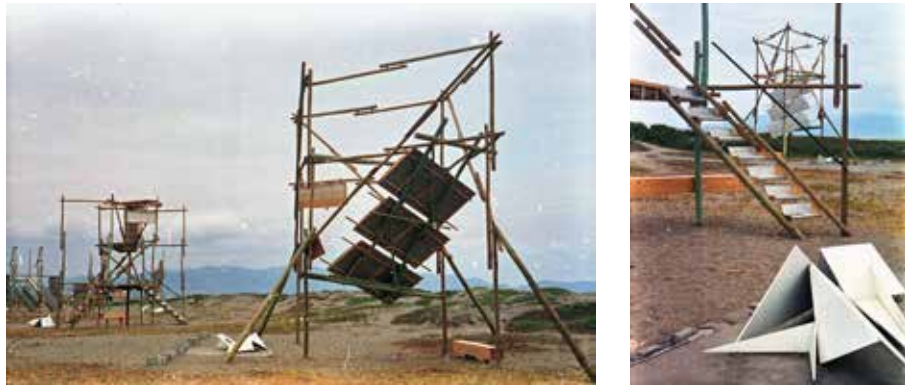
FIG. 3.23 Work constructed during the Travesía to La Serena. Chile, 1988. Source: Archivo Histórico José Vial Armstrong e[ad] PUCV.
