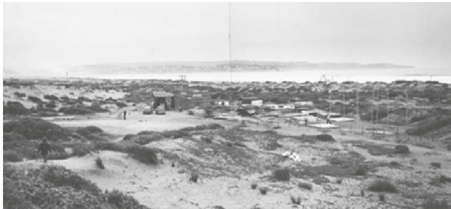
FIG. 1.11 Members of Ciudad Abierta constructing the first facilities: the construction site and the igloo. Ciudad Abierta , ca. 1972. Source: Archivo Histórico José Vial Armstrong e[ad] PUCV.
