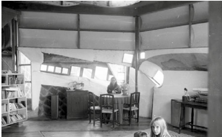
FIG. 1.42 Interior space of the Hospedería de la Puntilla . Ciudad Abierta , ca. 1980. Source: Archivo Histórico José Vial Armstrong e[ad] PUCV.
