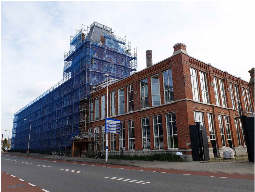
FIG. 6.4 Het Jannink under renovation, 2016.
