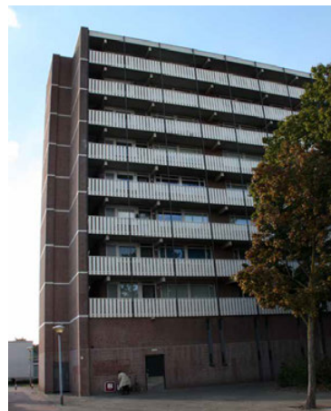
FIG. 4.18 BMB-woningen met galerijontsluiting in Woenselse Heide te Eindhoven, ontsluitingsgevel.
