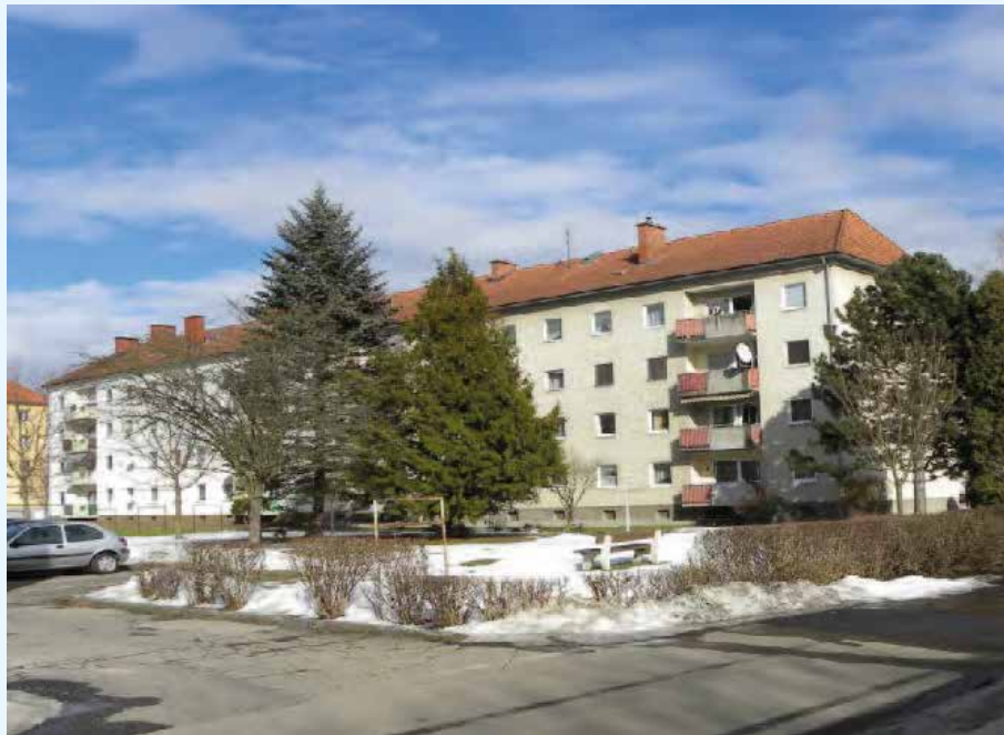
FIG. 5.13 Portieketageflat Kapfenberg (AT), bestaande situatie. Overgenomen uit Sanierung Johann Boehmstrasse door Ennstal, 2012. Copyright 2012, Nussmüller Architekten ZT GmbH.
