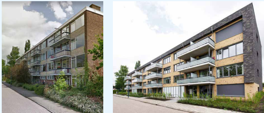
FIG. 5.9 Vooraanzicht flat aan Mr. S. van Houtenweg te Utrecht, oude situatie en nieuwe situatie. Links: overgenomen van Google Maps, 2019. Copyright 2019, Google Maps. Rechts: overgenomen uit Van Erpweg & Van Houtenweg, De Bilt (NL) door Sto z.d. ( https://www.sto.nl/nl/referenties/referenties-detail_76480.html ).
