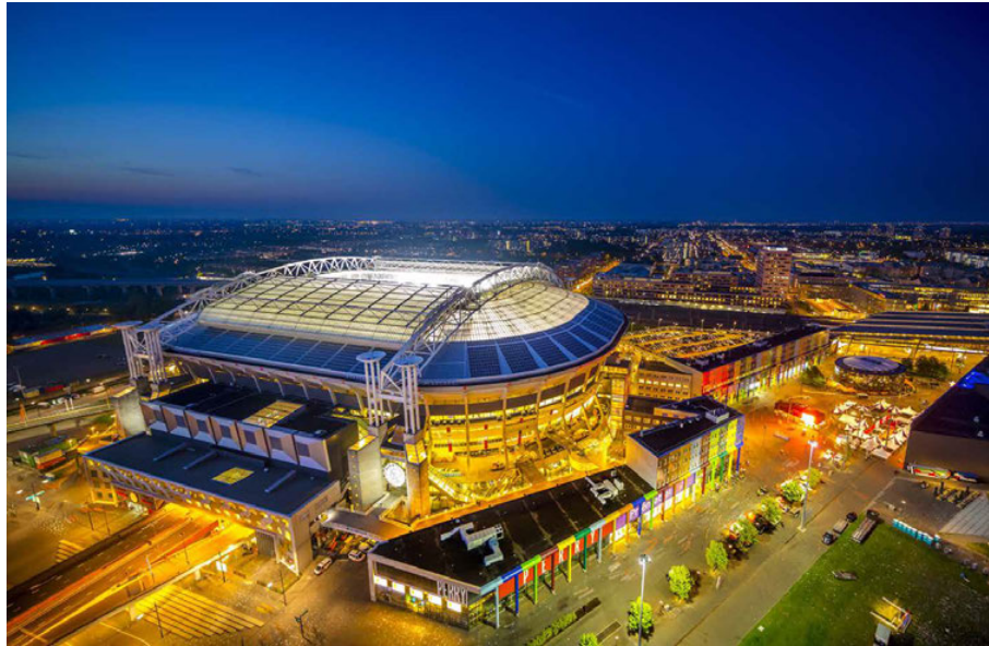
FIG. BIJL.7.1 Zonnepanelen en energieopslag voor de Arena. Foto overgenomen uit Grote batterij voor de Arena door A. Tissink, 2018. Copyright 2018, Cobouw.
