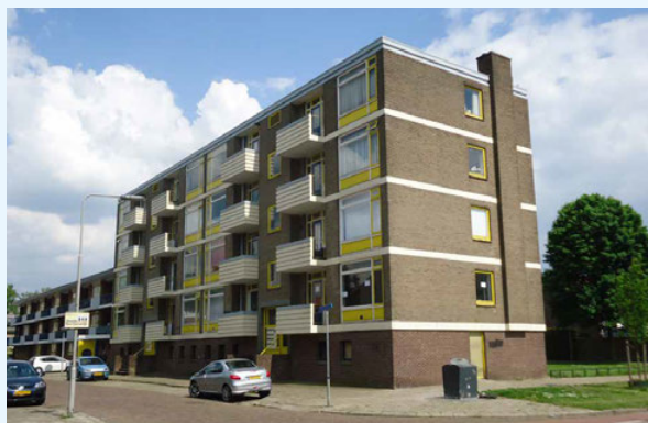
FIG. 5.5 Portieketageflat, Floriszstraat te Arnhem - situatie voor upgrading in 2014 en tijdens upgrading in 2015.
