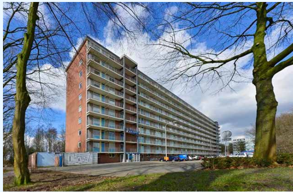
FIG. 5.2 Perosiflat Tilburg, bestaande situatie en gewijzigde situatie. Overgenomen uit Renovatie Perosistraat Tilburg, Noord-Brabant door Rijksdienst voor Ondernemend Nederland, 2014 ( https://www.rvo.nl/initiatieven/energiezuiniggebouwd/renovatie-perosistraat ). Copyright, Rijksdienst voor Ondernemend Nederland.
