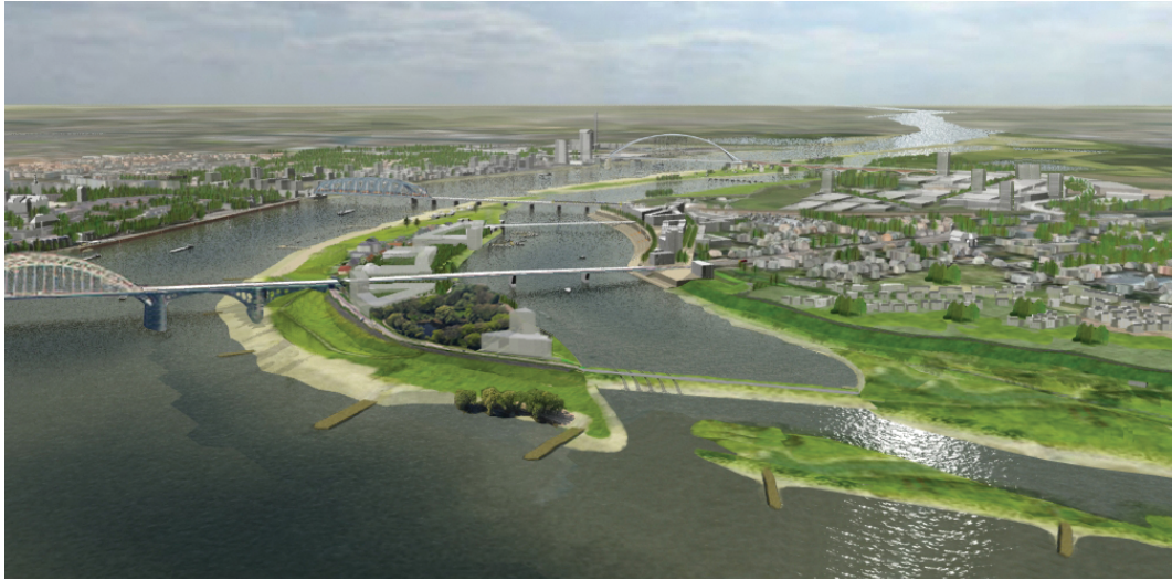
FIGURE 2.1 River bypass in Lent, near Nijmegen ( https://beeldbank.rws.nl , Rijkswaterstaat, Ruimte voor de Rivier / PDR)
