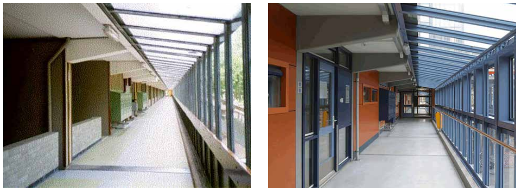
AFBEELDING 4.25 ‘Droogloop’ of ‘binnenstraat’ gerealiseerd (openbaar en met bergingen) in flat Gooioord in 1975 (links) en verbouwd (afgesloten en met woningen) in 2001 (rechts).
