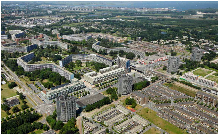
AFBEELDING 4.43 'I.H.V.'s' in deelplannen D en E uitgevoerd in 1975 (boven) en vernieuwd in 2011 (onder), gezien vanuit het zuiden, met op de voorgrond flats Kralenbeek, Kempering, Kleverink en Kouwenoord (onder alleen de overgebleven hoogbouw met vervangende laagbouw), daarachter de Karspeldreef met garages (onder met vervangende nieuwbouw) en metrostation Kraaiennest (boven in aanleg), daarachter het 'Bijlmer Museum' en op de achtergrond de buurten Geerdinkhof en Kantershof in laagbouw (boven in aanbouw, onder geheel op de achtergrond IJburg in aanbouw).
