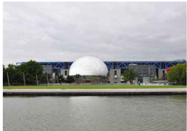
b View across the Canal de l'Ourcq to Cité des Sciences et de l'Industrie. (Photo: Author)
