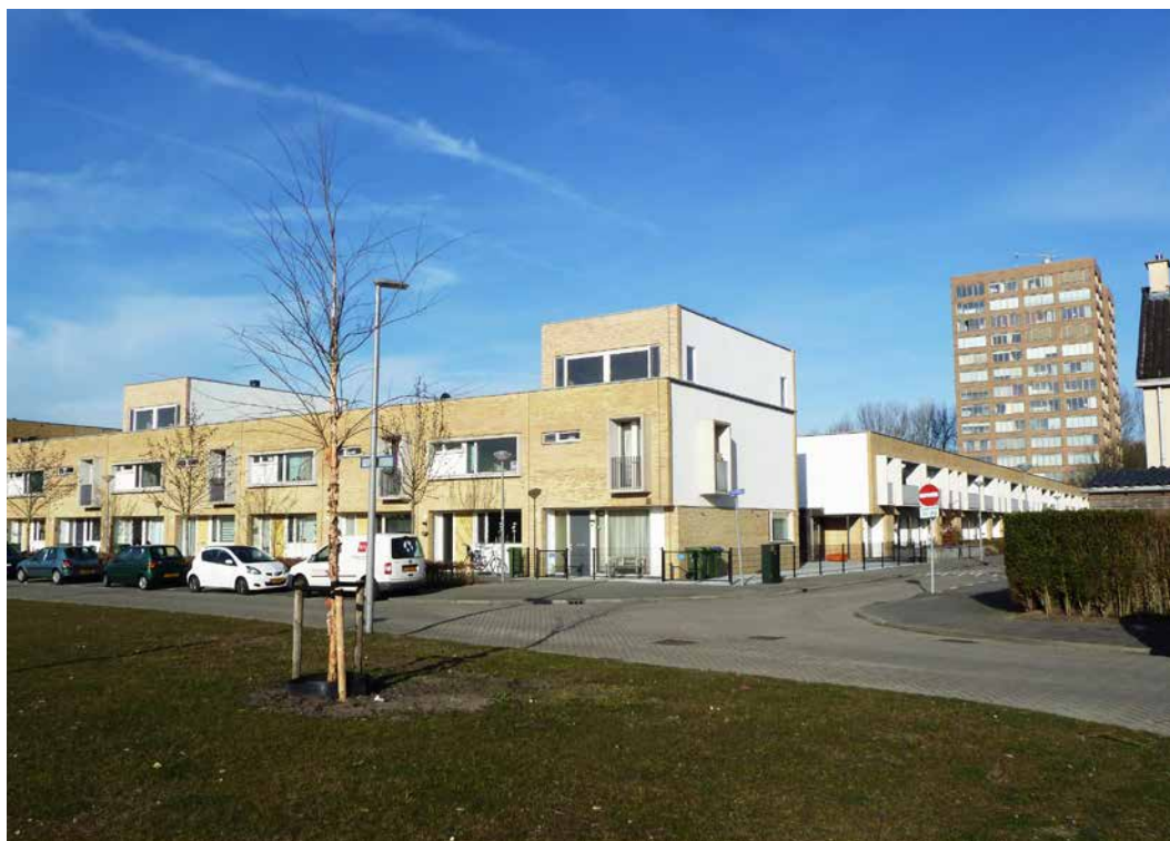
FIGUUR 7.5 Nieuwbouw in de Burgen
