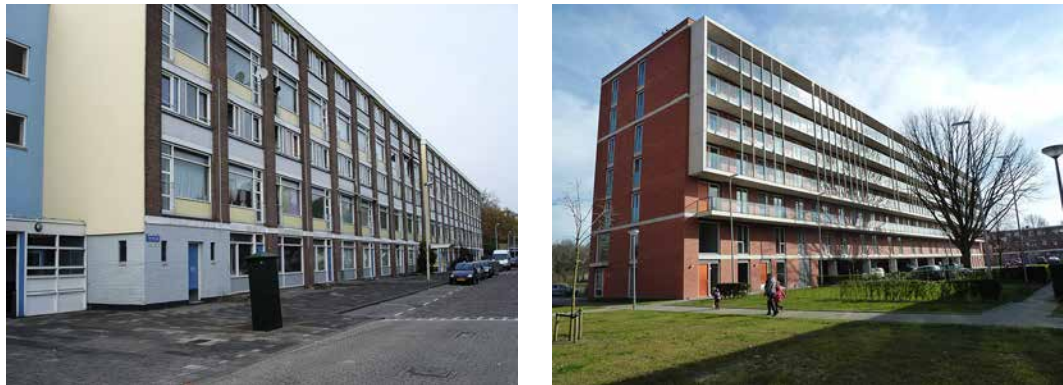
FIGUUR 9.3 Sloop gevolgd door nieuwbouw van sociale huurwoningen aan het Bornerveld
