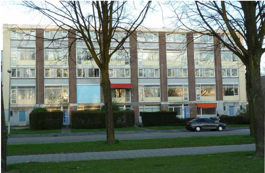
FIGUUR 7.2 Te slopen maisonnettewoningen aan het Brekelsveld
