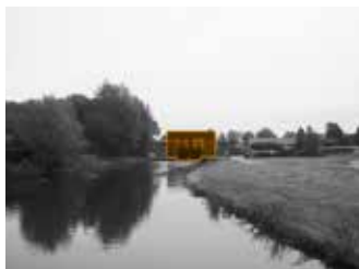
ILLUSTRATIE 7.79 Het gemaal De Kooi is zowel vanaf de Rotte als ook vanuit de polder door zijn maat goed zichtbaar. Vanuit de polder beëindigt het gemaal de brede vaart.
