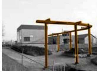
ILLUSTRATIE 3.45 De moderne gemalen zijn voorzien van een vuilvang. De bewegende 'hark komt automatisch in actie als groef materiaal in het polderwater ligt en verwijdert deze.
