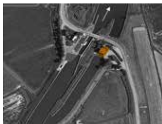
ILLUSTRATIE 4.14 Boezemgemaal De Waakzaamheid.
