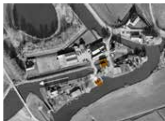
ILLUSTRATIE 4.38 Tussen-boezemgemaal Bovengemaal.
