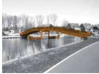
ILLUSTRATIE 7.98 Hoge brug over de Rotte.
