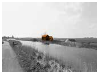
ILLUSTRATIE 7.117 Het gemaal Binnenwegsepolder fungeert, ook al is het heel klein, door zijn uitzonderlijke positie op de Rottedijk als 'landmark' met een reikwijdte tot aan de horizon.
