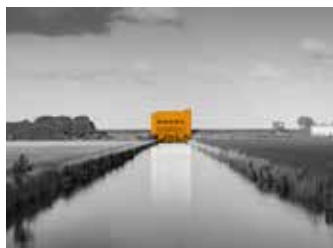
ILLUSTRATIE 3.41 Elektrisch poldergemaal: deze aandrijftechniek kent geen specifiek uiterlijk en maat. Twee uitersten zijn het poldergemaal Lely en de anonieme kastje langs het Amsterdam Rijnkanaal.
