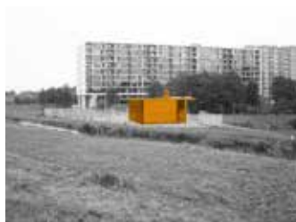
ILLUSTRATIE 7.82 Het gemaal Ommoord is omringd door een dominant aanwezig hekwerk.
