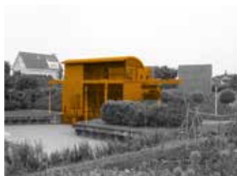
ILLUSTRATIE 7.81 Het gemaal Leemhuis-Stout is hoog aan de polderzijde, laag aan de Rottezijde.
