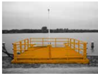
ILLUSTRATIE 7.100 Inlaat van Rottewater uitgewerkt als balkon.
