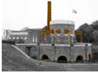
ILLUSTRATIE 3.38 Stoomgemaal: is een imposant en krachtige installatie die water van een lager naar een hoger waterpeil brengt. De stoomgemalen Cruquius en Wouda (beiden Unesco werelderfgoed) zijn groot en visueel opvallend. Het uiterlijk van de waterwerken wordt bepaald door de schoorsteen en de massieve uitvoering van het gebouw, soms is de aandrijftechniek zichtbaar.
