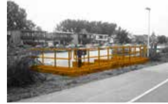
ILLUSTRATIE 3.46 Uitlaat: waterwerk dat aan de bovenkant van de dijk ligt en de plek versterkt waar het water, meestal onder de waterlijn, vanuit het gemaal in de boezem of het buitenwater stroomt.
