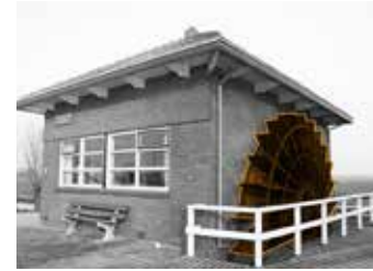
ILLUSTRATIE 3.40 Dieselmol met scheppraad: vele combinaties van aandrijving en opvoer zijn mogelijk zoals hier bij het gemaal Langerak.
