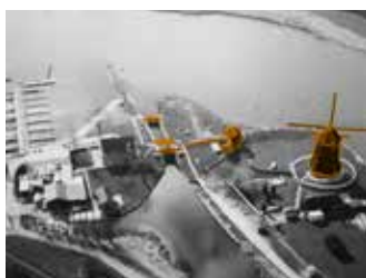
ILLUSTRATIE 7.120 Het waterwerken-ensemble op de kaap van de Rotte Meren.
