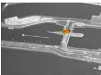
ILLUSTRATIE 4.25 Boezemgemaal en spuisluisen Ijmuiden.
