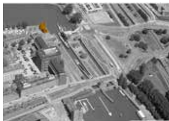
ILLUSTRATIE 4.34 Boezemgemaal Parksluizen en sluizen.
