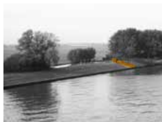
ILLUSTRATIE 3.42 Elektrisch poldergemaal: deze aandrijftechniek kent geen specifiek uiterlijk en maat. Twee uitersten zijn het poldergemaal Lely en de anonieme kastje langs het Amsterdam Rijnkanaal.
