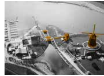
ILLUSTRATIE 7.86 Het tussenboezemgemaal Hennipsloot in het midden op de foto vormt samen met de molen en de sluis een ensemble. De molen en de sluis behoren tot beeldelementen van het veenlandschap.
