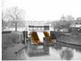
ILLUSTRATIE 3.39 Poldergemaal met vijzel: deze waterwerken staan altijd boven aan de dijk, zo als hier het gemaal Leyens. De opmaattechniek, de vijzel is goed zichtbaar. Een stalen vijzel kan maximaal een hoogte van 4-5 meter overbruggen en bestaat tegenwoordig veelal uit een wormschroef van twee of drie gangen die in elkaar gedraaid zijn.
