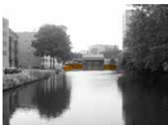
ILLUSTRATIE 7.35 De trechtvormige kade voor het gemaal.
