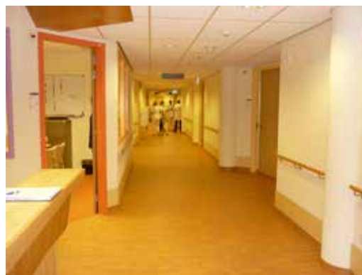
FIGUUR 7.53 gang met witte wanden, wit systeemplafond en gele linoleum vloer
