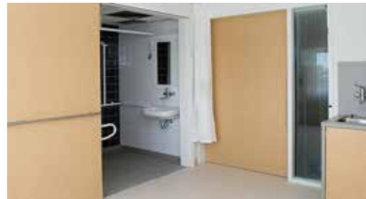
FIGUUR 11.46 patiëntenkamer tijdens de bouw
