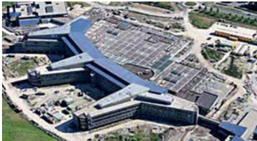
FIGUUR 7.188 luchtfoto complex
